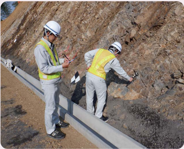
▲野村ダム堰堤改良PPPチーム 岩質確認状況
