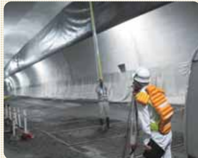
覆工コンクリート基準高の確認状況
