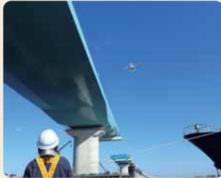
四国横断道PPPチーム 新町川橋中央径間架設前のドローンによる現況確認
