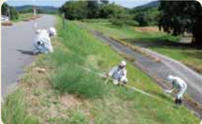
高知河川管理施設監理検討業務 堤防法勾配の確認
