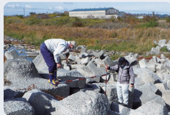
▲松山河川施設管理部会 重信川施設点検
