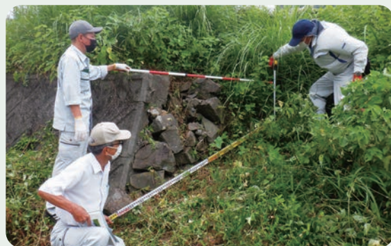
▲高知河川管理施設監理検討業務(護岸変状の確認状況)
