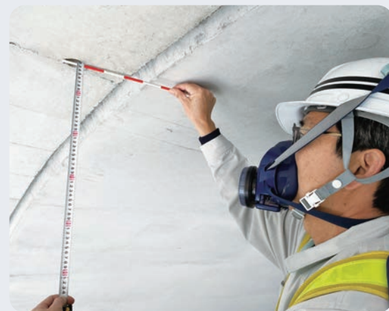
▲覆工コンクリート出来形(覆工厚さ確認状況)
