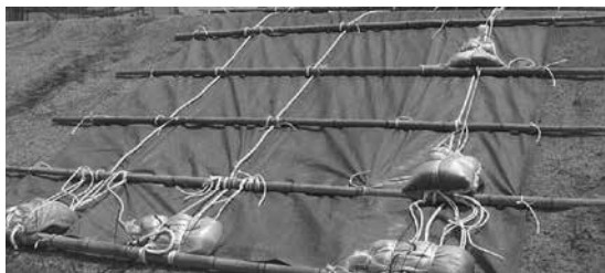
上記写真は骨竹を取り付けた状態
