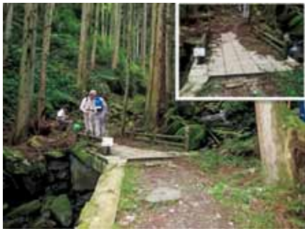
コンクリート橋
