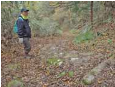
急勾配箇所石張りの様子
