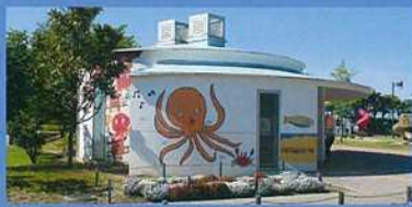
「セルフイーアル」は、不特定多数の人たちが利用する公衆トイレの施工にお薦めします。写真は、道の駅「恋人の聖地うたづ臨海公園」のたこさんトイレ。
