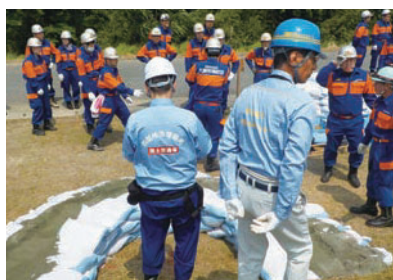
▲肱川水防工法訓練 （大洲市 肱川防災ステーション）
