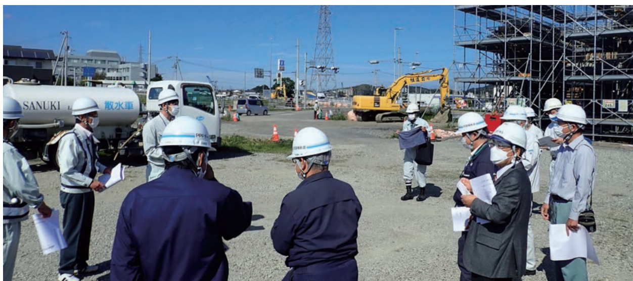
▲橋梁エキスパートと現地踏査(徳島道路事業監理室)
