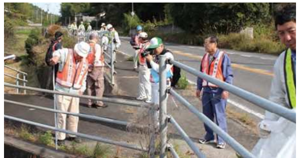
▲香川道路施設管理部会:一般国道32号 施設点検
