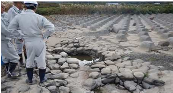
▲松山河川施設管理部会:重信川 施設点検
