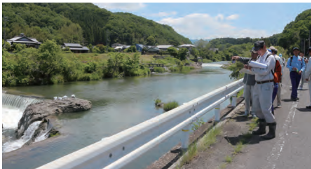
▲香川河川施設管理部会:土器川左右岸 施設点検
