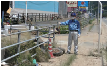
▲道路調査班 側溝の土砂堆積状況調査
