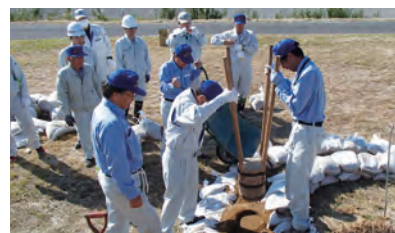
▲月の輪工 工法指導(松山市)
