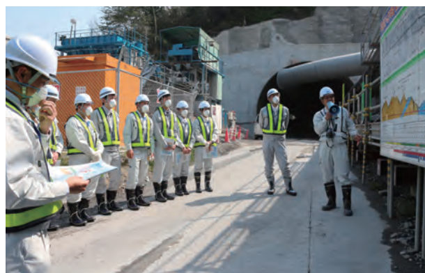
▲新猪ノ鼻トンネル工事現場見学(新規採用者研修)
