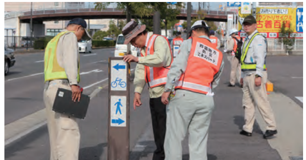
▲香川道路施設管理部会:一般国道11号 施設点検
