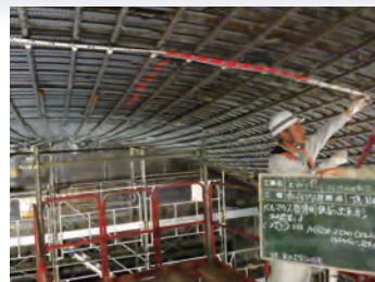
大洲支所 技術部
